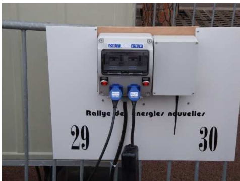
Panneaux de recharge avec compteurs d'énergie dans le Parc Fermé / Recharging panels with meters in the Parc Fermé
