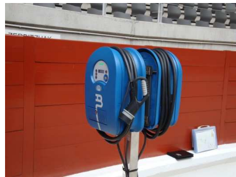
Panneaux de recharge avec compteurs d'énergie dans le Parc Fermé / Recharging panels with meters in the Parc Fermé
