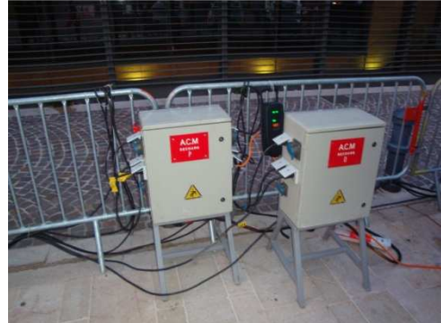
Panneaux de recharge portables avec compteurs d'énergie / Portable recharging panels with meters
