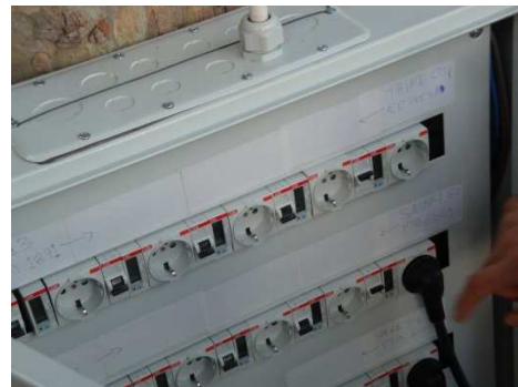
Panneaux de recharge avec compteurs d'énergie dans le Parc Fermé / Recharging panels with meters in the Parc Fermé
