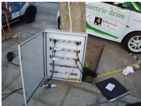
Panneaux de recharge avec compteurs d'énergie dans le Parc Fermé / Recharging panels with meters in the Parc Fermé
