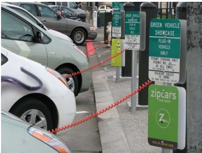
Φόρτιση αυτοκινήτων σε δημόσιο δρόμο
